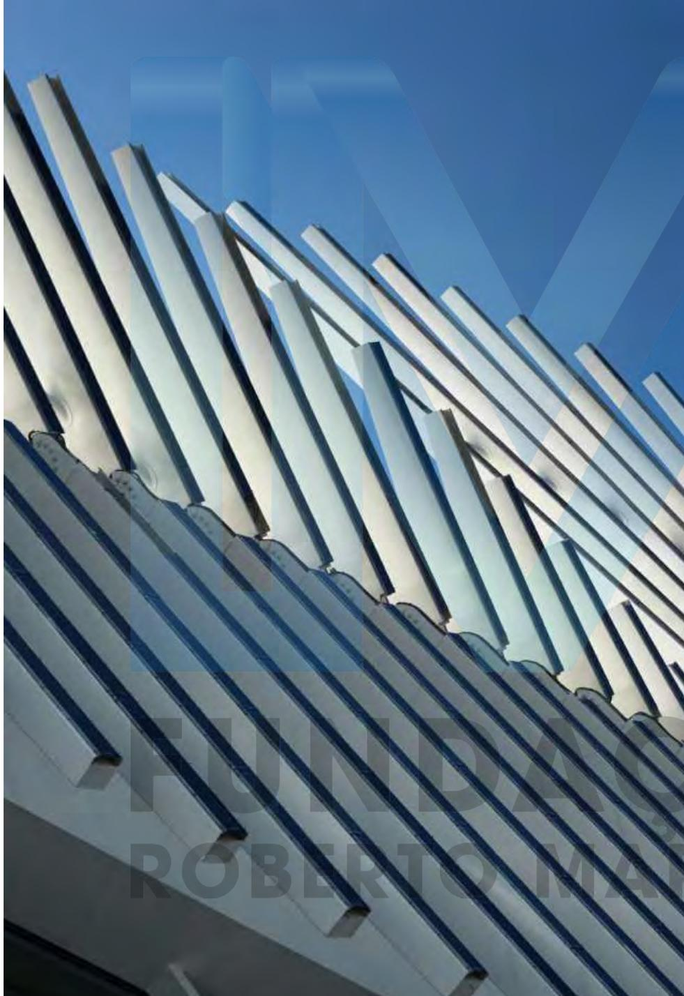
Parte da energia utilizada no edifício é gerada pela captação de energia solar: as grandes estruturas de aço instaladas em sua cobertura móvel servem de base para placas fotovoltaicas e, ao longo do dia, se movimentam como asas para acompanhar o posicionamento do sol.
