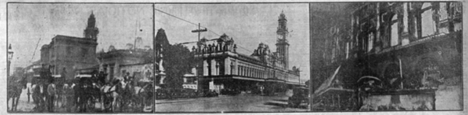
A esquerda, a primitiva Estação da Luz, construída em estilo francês e com um jardim; ao centro, o atual edifício da estação, em estilo neoclássico; à direita, a estação em ruínas, após o incêndio de 1946.
