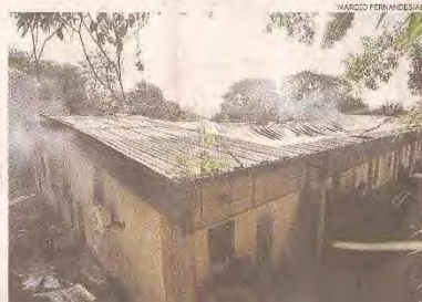
Condenado. Prédio das Coleções, que será demolido
