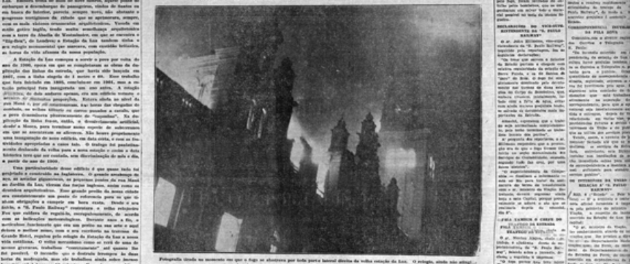
Incendiários, em número de cerca de 100, lutam para controlar as chamas que se elevam das ruínas da estação da Luz. O fogo, que se iniciou às 2 horas e 15 minutos da madrugada, destruiu a estação em poucos minutos.
