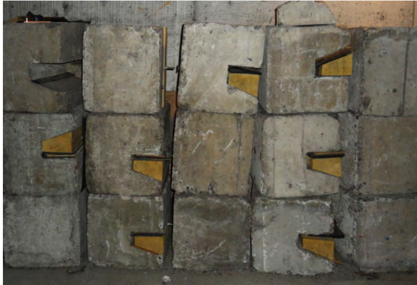
Estado de conservação dos cavaletes existentes
