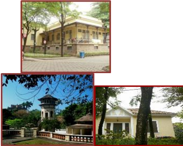
Figura 3 - Edifícios do Conjunto Eclético: Hospital Evandro Chagas, Pombal, Casa Amarela. Fonte: Acervo DPH/COC
