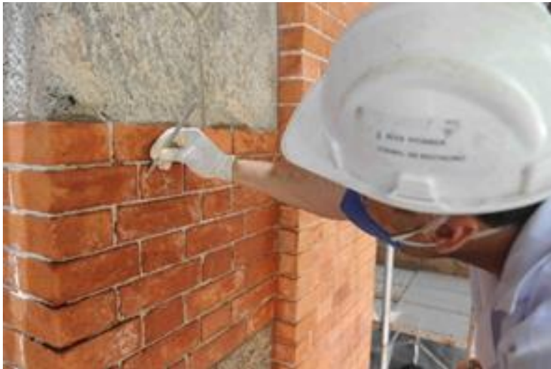
Figura 12 - Restauração dos tijolos aparentes da fachada (2014-2015). Fonte: DPH/COC/Fiocruz
